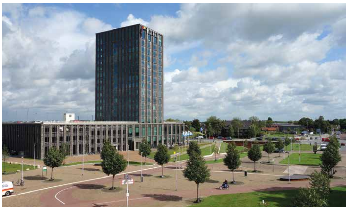
Nieuwbouw hotel Van der Valk.
